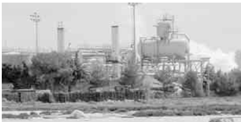
DA LUNEDÌ ACQUA ANCORA RAZIONATA PER I LAVORI ALL'IMPIANTO DI NUBIA
