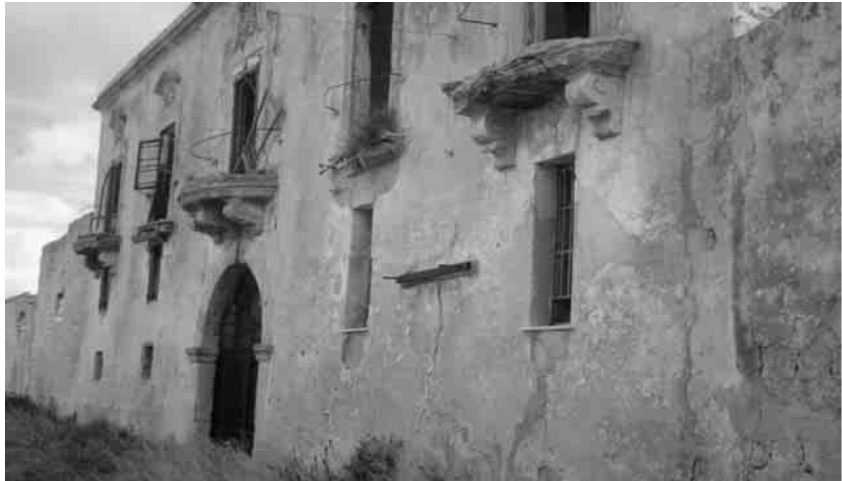
Un baglio abbandonato in contrada Selvaggi, a Marsala
